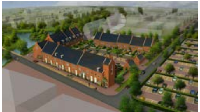
Nul-op-de-meter woningen ontworpen in Delftse School stijl. Met bodemwarmtepompen en PV, opgeleverd 2017. Ontwikkelaar AM, uitgevoerd door BAM Woningbouw.
