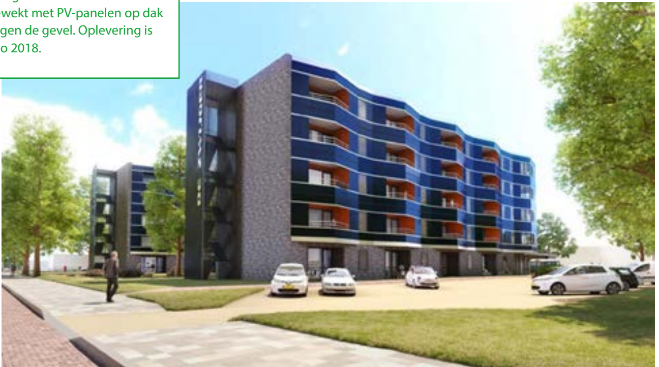
48 NOM-appartementen in Best met bodemwarmtepomp en PV-panelen op het dak en tegen de gevel.
