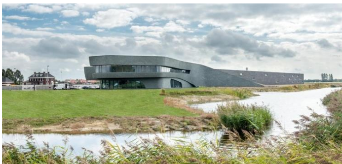
Bouwbedrijf Boogert investeert in nieuw bedrijfspand te Oosterland
